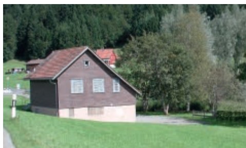
Staumauerstrasse 22 8847 Egg SZ
